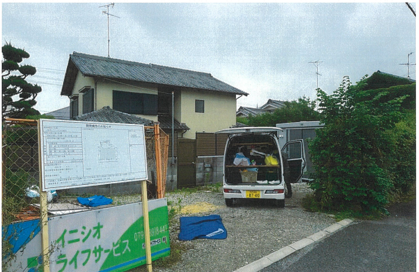
北側道路面 看板設置
